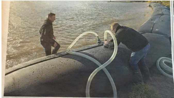
De mobiele nooddam wordt getest bij het recreatiegebied Salmsteek. Het gevorta wordt uitgerold en gevuld met water... en klaar is Kees. FOTO MENDO BAUSCH
