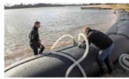
De mobiele nooddam wordt getest bij het recreatiegebied Salmsteek. Het gevorta wordt uitgerold en gevuld met water... en klaar is Kees. FOTO MENDO BAUSCH
